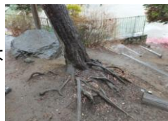
～流出した表土～
