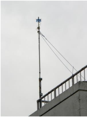
図2 屋上設置例(小金井市・東京学芸大学自然科学研究棟屋上)
