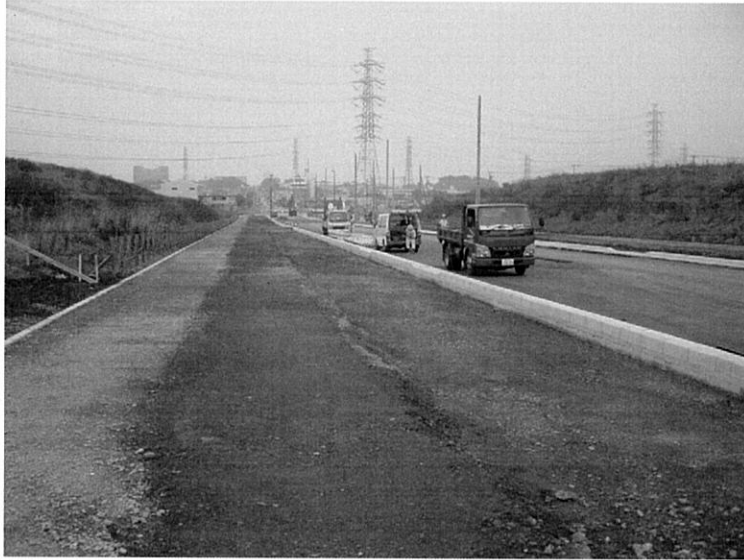
写真1 国道246号線の工事の様子
