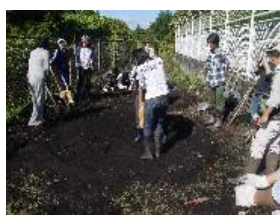
基礎工事の様子
