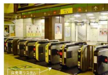
JR 東京駅で行われた床発電 システムの実証実験
