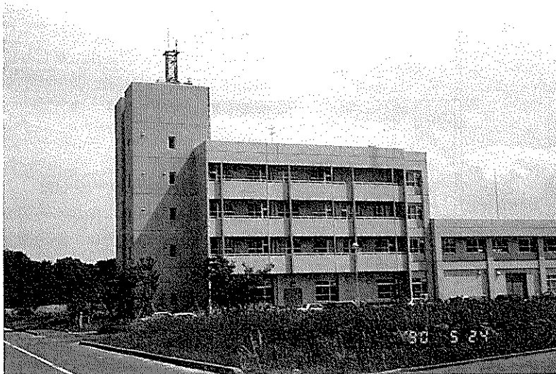
写真1. 測定システム設置建物
