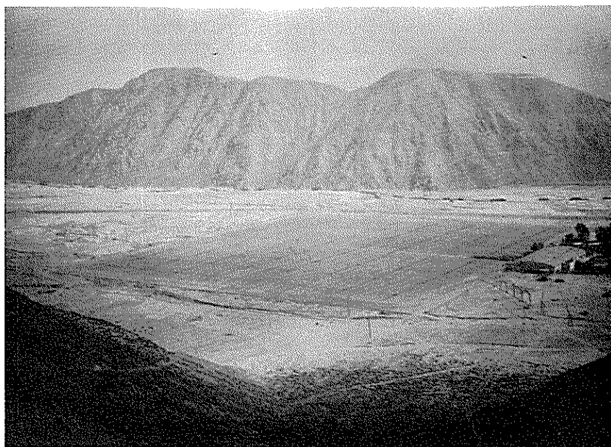
図 2 ヒカマルカレーダアンテナ 300 m×300 m の平地に約 10,000 本のアンテナが並ぶ使用電波周波数約 50 MHz
